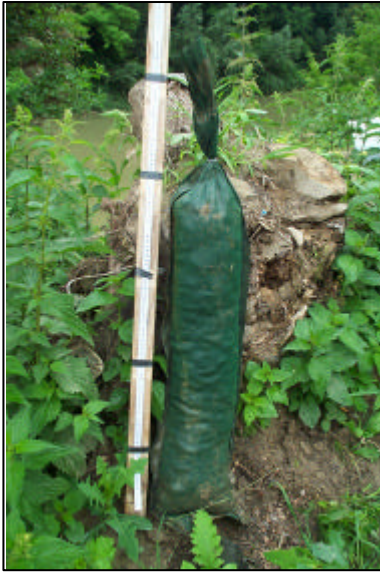
Abb. 4: Gefüllter Silosandsack zur Abdichtung des Fischwehrs
