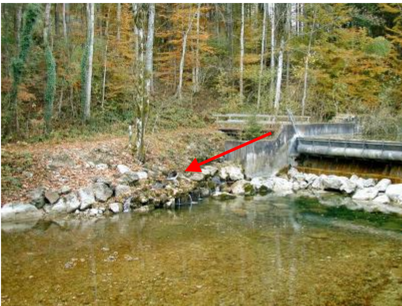
Abb. 2: Die Fischaufstiegsanlage der Fa. Ebewe (roter Pfeil) ist anhand konstruktiver Kriterien als nicht funktionstüchtig einzustufen
