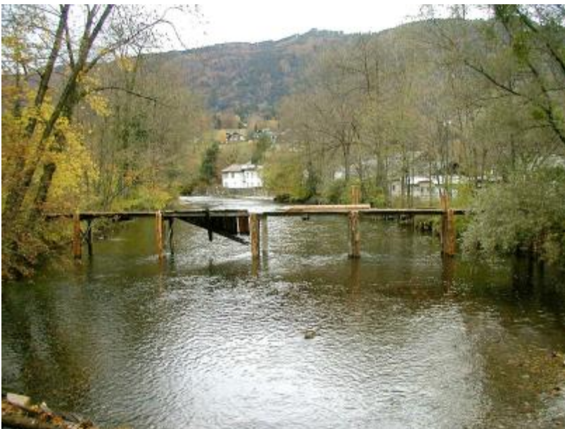
Abb. 1: Diese Steganlage eignet sich für die Applikation von Reusen hervorragend
